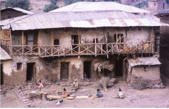
Chickahus, dvs ett hus byggt av lera på träpålar. Bottenvåning av stenmur som putsats med lera och målats med kalk.
