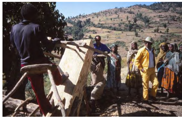
Sågning av träplank på landsbygden. Det var svårt att få tag på sågade träprodukter. För det mesta användes eukalyptuspålar när man byggde.
