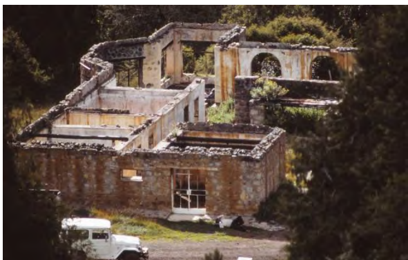
Dincho lodge innan återuppbyggnaden. Huset ligger vid Bale nationalpark som är belägen på i genomsnitt 3,000 meters höjd.
