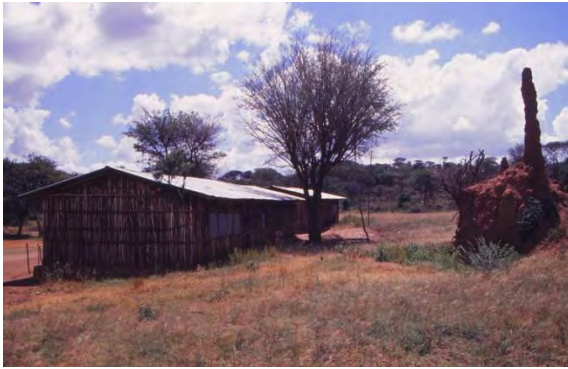
Skola byggd intill termitstack. Termitjord är hård då termiterna blandar jorden med limämnen de utsöndrar när de äter gräs och trämaterial.
