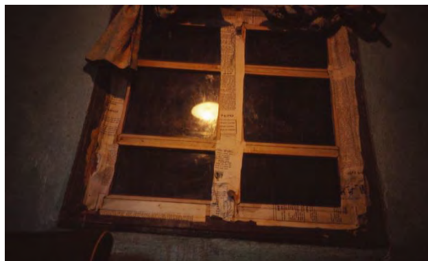
Fönster i ett hotellrum jag sov i. Pappersremsor har klistrats över skarvarna för att undvika att bin, som bodde mellan glasrutorna och de utvändiga fönsterluckorna, skulle komma in i hotellrummet.
