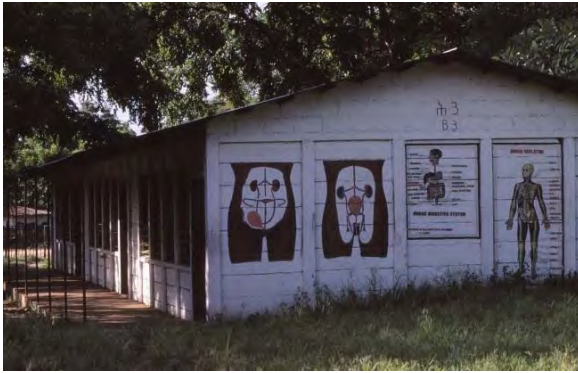
En av de tidiga svenskfinansierade skolorna, byggda av betongelement som gjöts på plats.
