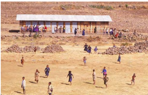
En av två byggnader med klassrum för en grundskola. Väggarna skall täckas med lera men man väntar på regn så att jorden kan bli blöt.
