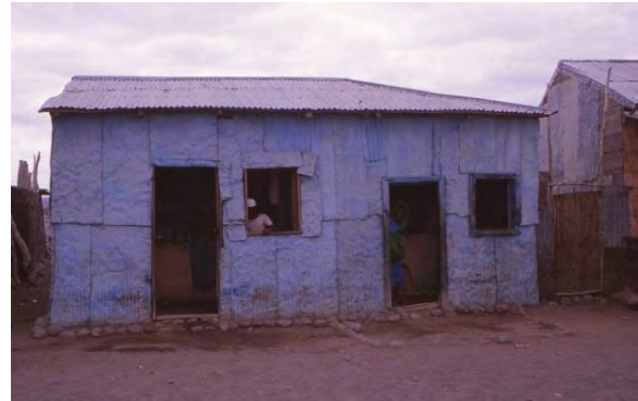
Affär i smugglarbyn Paradiso på väg mot Assab. Väggarna är utbankade asfalttunnor från asfalteringen av vägen till Assab.
