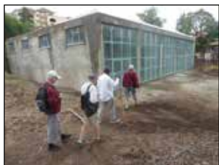
Bottenplanet på Air Forceveteranernas byggnad i Bishoftu står klar.
