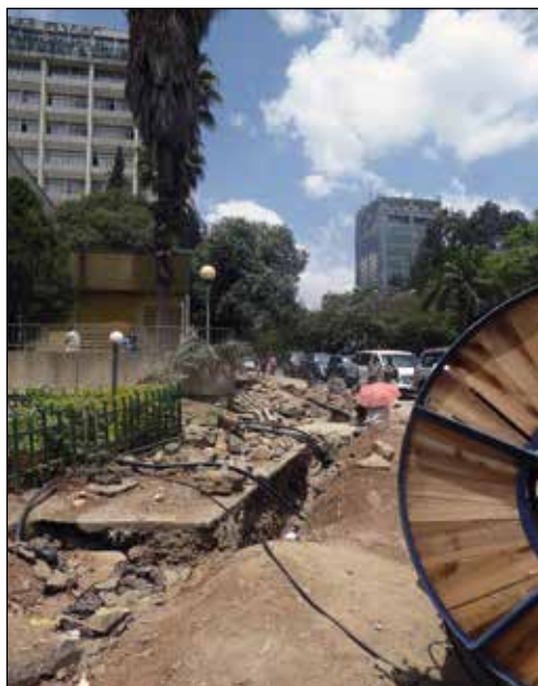
Överallt i centrala Addis grävs det för fiberkablar till internet.
