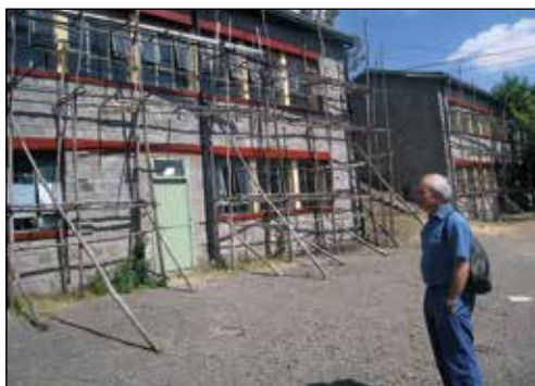
Redan har ett omfattande renoveringsarbete utförts. Karl-Erik betraktar fasaden som mejslats ner för hand för att den ursprungliga ytan ska komma fram.
