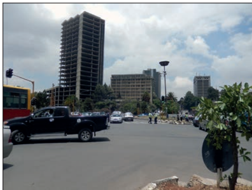
Nybyggnation i centrala Addis.
